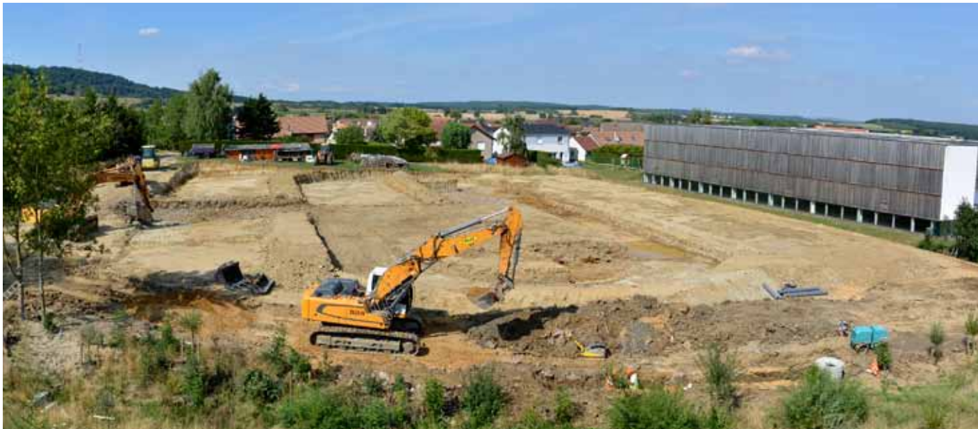
Vue d'ensemble de la plateforme qui accueillera les pavillons seniors
