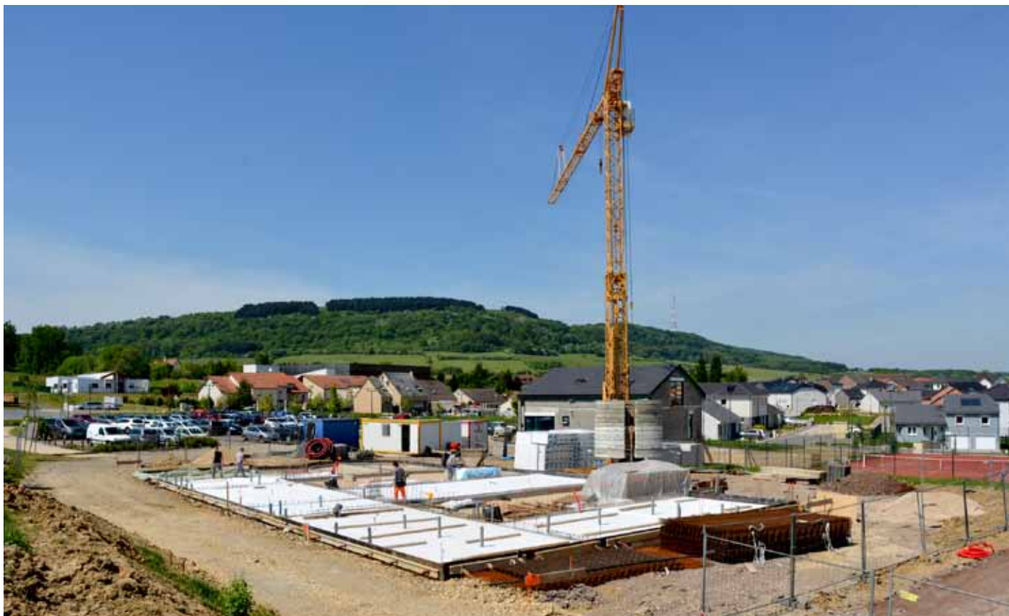
Les travaux de l'espace socio-culturel avancent à grands pas
