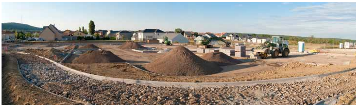
L'aménagement de l'entrée du village se poursuit avec la création du parking de covoiturage et des cellules commerciales
