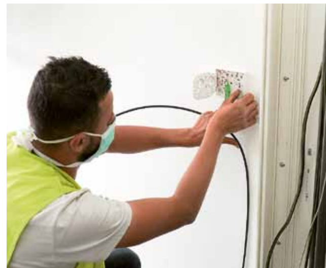
Photo du haut : le technicien raccorde le câble venant d'une habitation au réseau fibre optique situé dans la rue.
